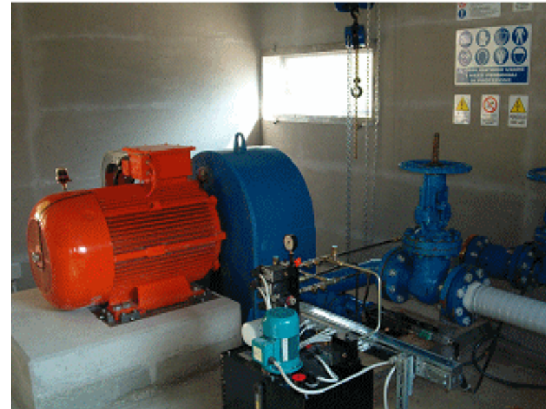
Turbina in tubazione acquedotto
