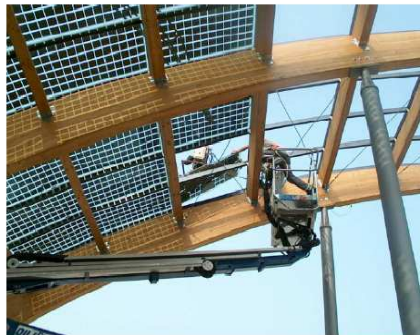
Fig. 5 Montaggio moduli fotovoltaici in vetro/vetro
