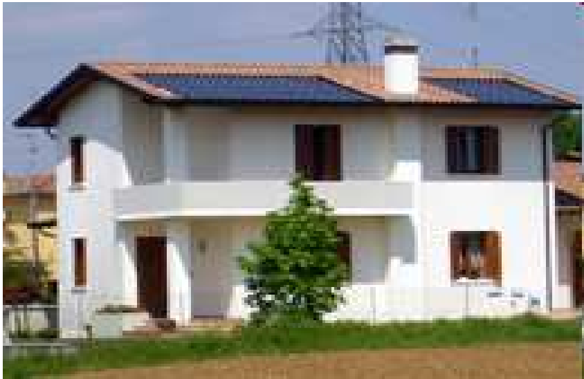
IMPIANTO INTEGRATO 3 kW
