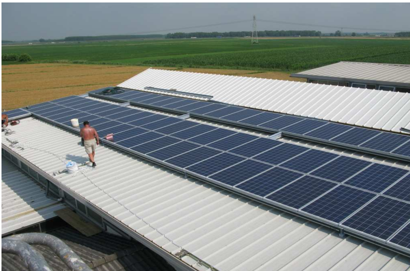
IMPIANTO SEMI INTEGRATO 19 kW
