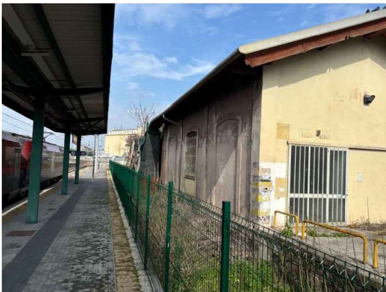
Fronte ovest – lato binari
