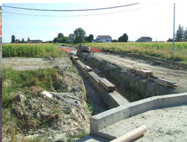
Realizzazione dell'intervento di consolidamento del sottofondo dei rilevati con la tecnica del deep mixing a cemento
