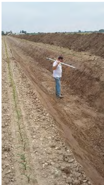
Esecuzione del fossato verso sud
