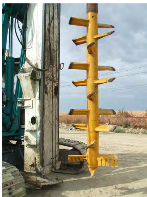
Realizzazione dell'intervento di consolidamento del sottofondo dei rilevati con la tecnica del deep mixing a cemento
