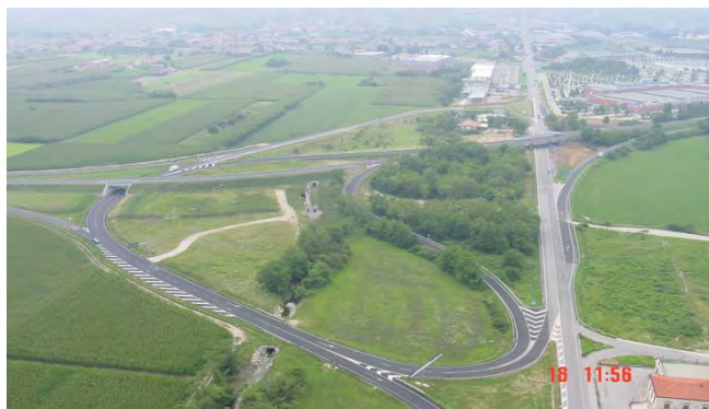
FOTO 1 – Collegamento con la S.S. 13
