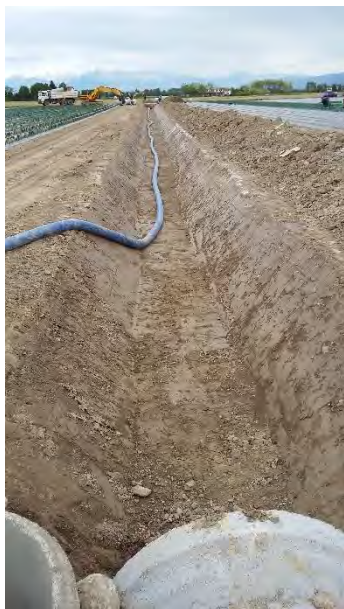
Esecuzione del fossato verso sud
