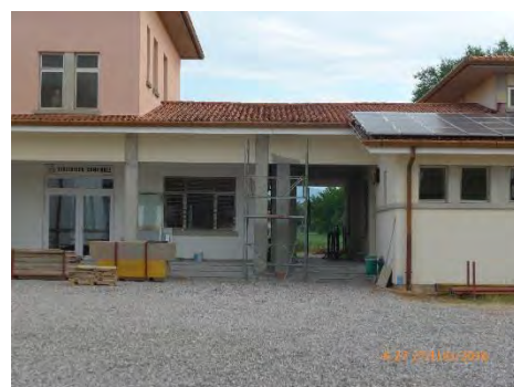
Realizzazione giunto sismico
