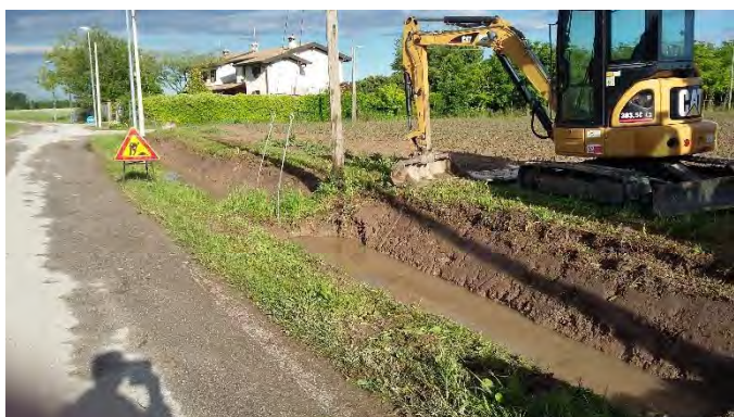
Ricalibratura del fossato di monte
