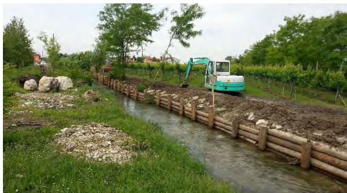
Opera di difesa spondale e costruzione del rilevato arginale
