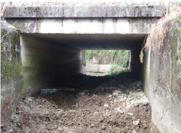
Attraversamento ferroviario PRIMA dell'intervento
