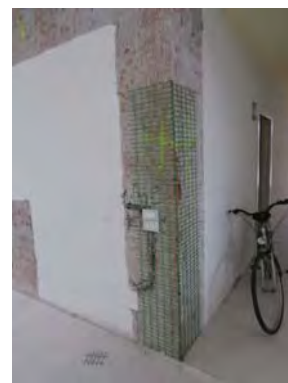
Rimozione dell'intonaco e posa della rete in FRP
