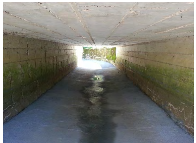
Attraversamento ferroviario DOPO l'intervento
