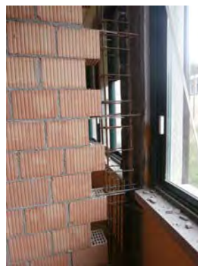
Incrocio nuova muratura sismoresistente con pilastro
