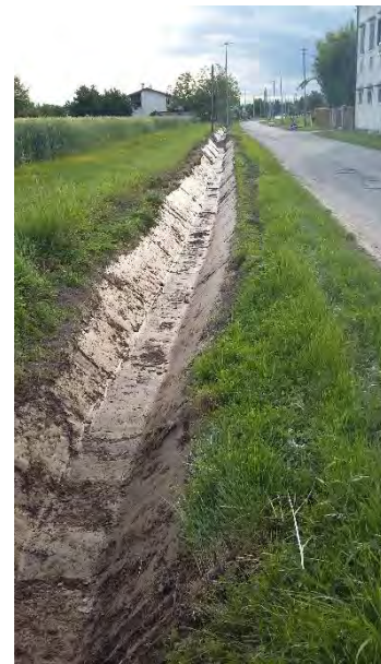
Ricalibratura del fossato di valle
