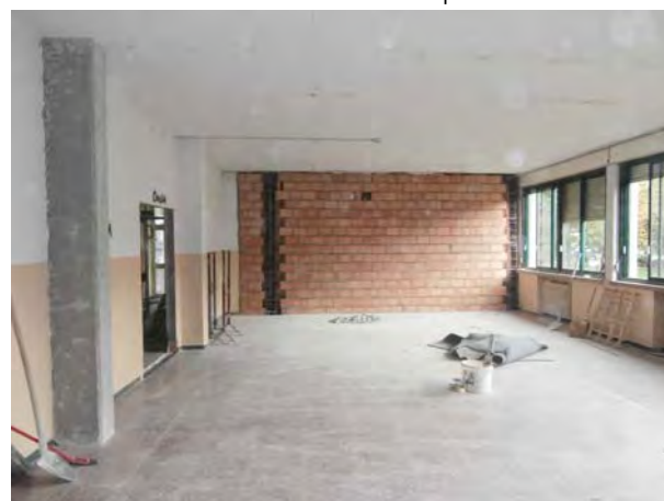
Intervento su parete in muratura
