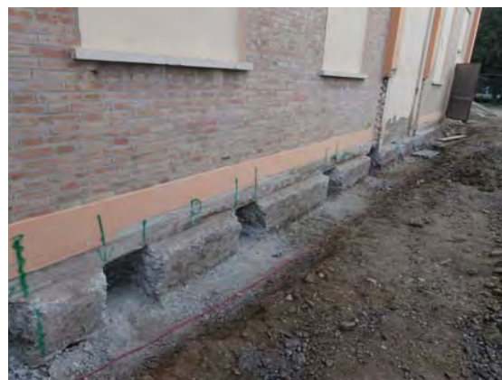
Interventi di rinforzo delle fondazioni esistenti
