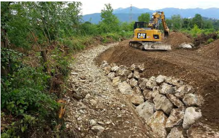
Realizzazione della nuova scogliera
