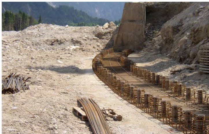
I pali e la ricostruzione della sponda
