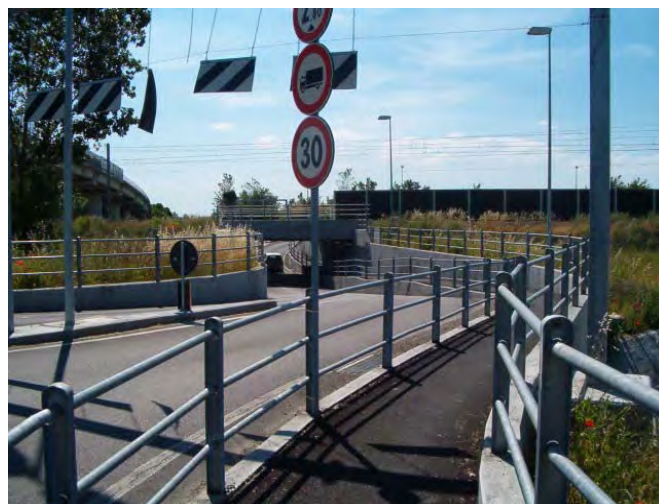
Sottopasso in Comune di Poggiorusco
