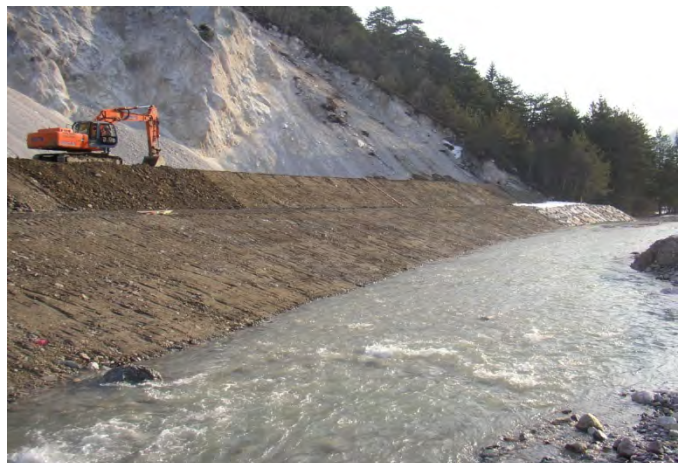
I pali e la ricostruzione della sponda
