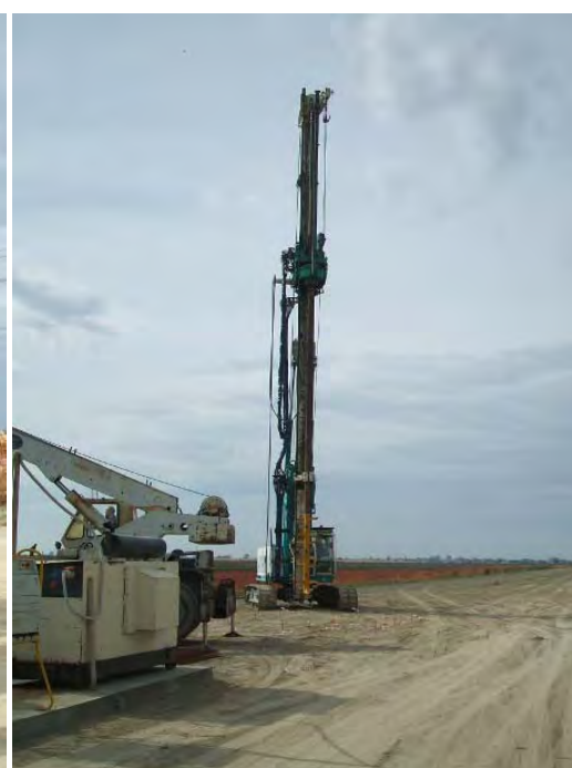
Realizzazione dell'intervento di consolidamento del sottofondo dei rilevati con la tecnica del deep mixing a cemento
