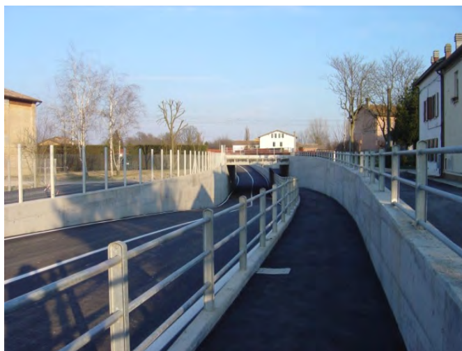
Sottopasso via 1° Maggio (S. Felice sul Panaro)
