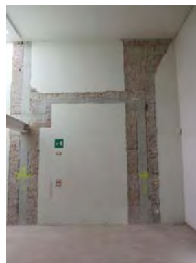
Rimozione dell'intonaco e posa della rete in FRP
