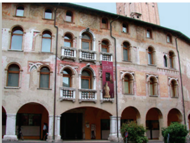
Palazzo Ricchieri, facciata esterna.
