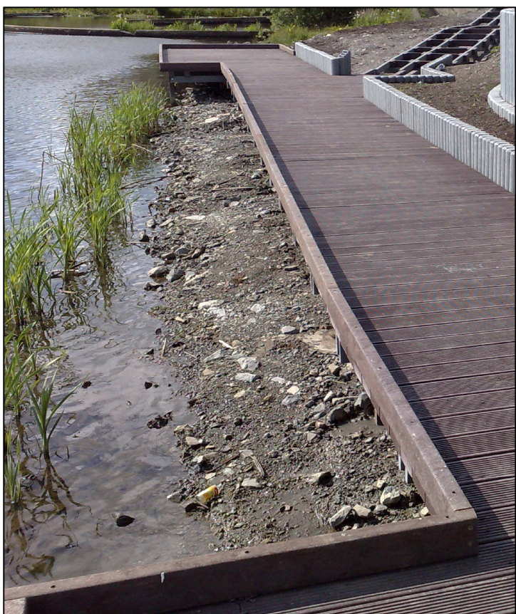
Particolare 2 - Pontile con tavole in plastica riciclata
