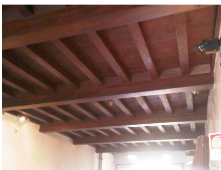
Fig. 2: Vista atrio di ingresso dal Corso Vittorio Emanuele II, particolare del solaio in legno
