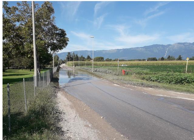
Figura 2- Allagamenti recenti in via delle Villotte. In particolare, nella foto qui sopra a destra, si nota il profilo stradale a “corda molle” ove l’acqua tende a ristagno.
