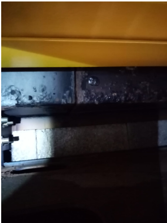
Figura 8 – Stato di fatto gronda
