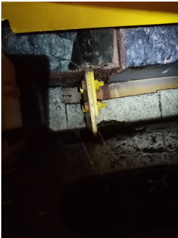
Figura 6 – Stato di fatto gronda
