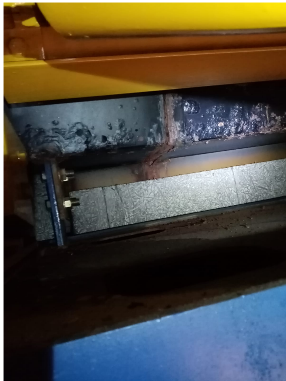
Figura 7 – Stato di fatto gronda
