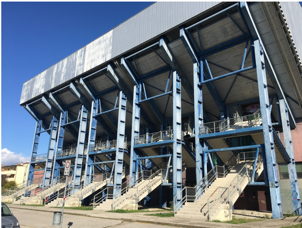
Figura 1 – Telai principali lato via Fratelli Rosselli
