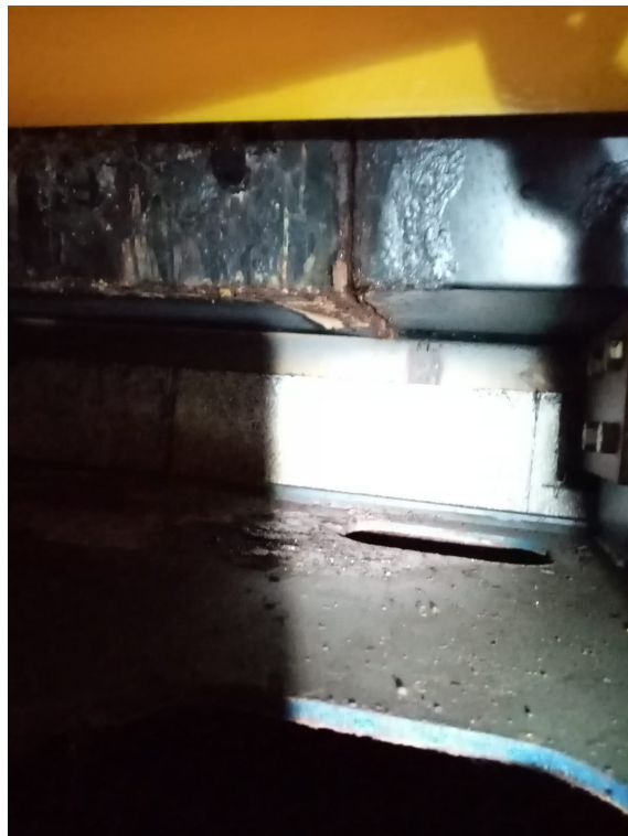
Figura 9 – Stato di fatto gronda
