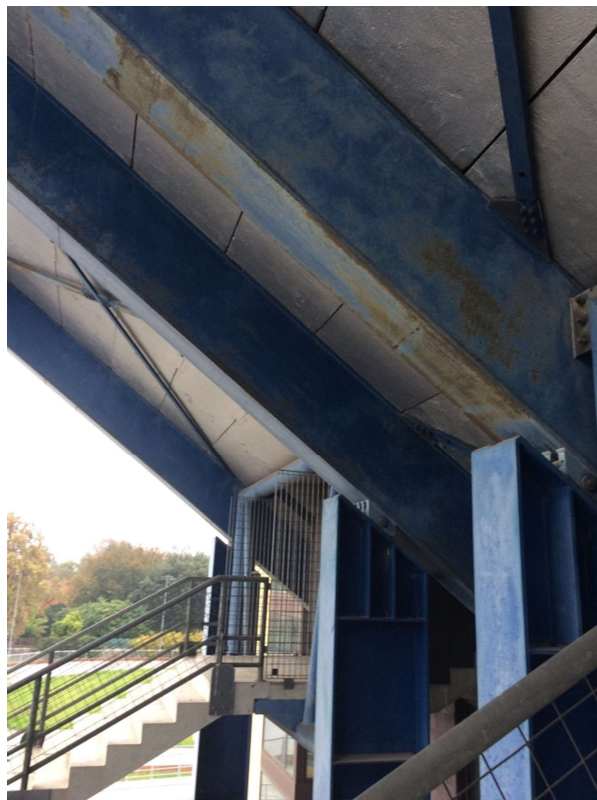
Figura 4 – Azione di ossidazione su elementi del telaio
