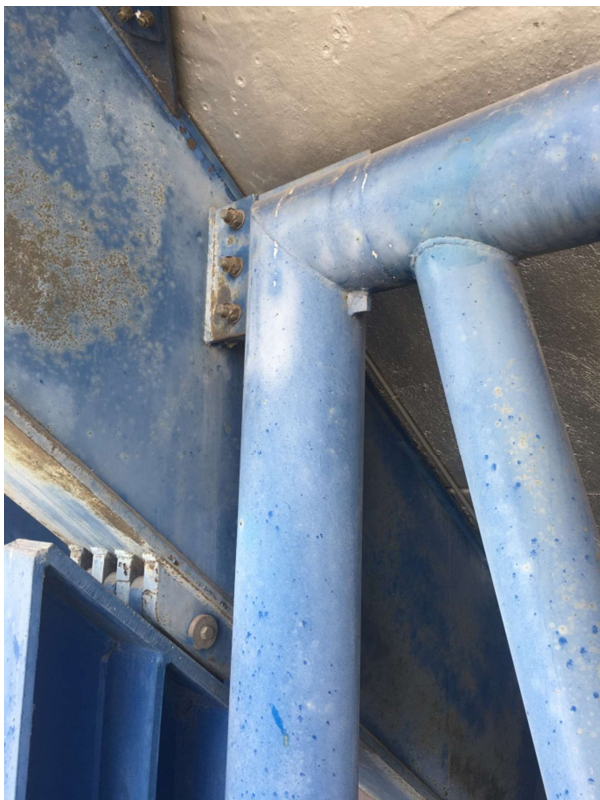
Figura 3 – Particolare unione bullonata telaio
