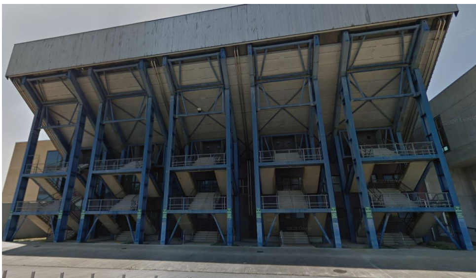
Figura 2 – Telai principali lato via Interna
