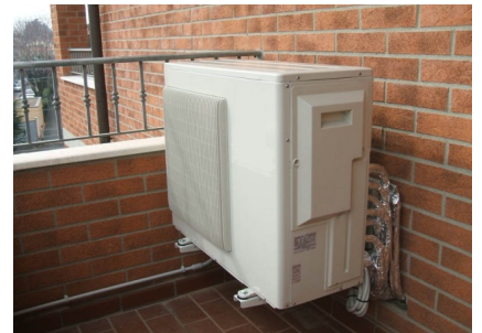
Unità esterna condizionatore: esempio di posizionamento per ridurre impatto visivo
