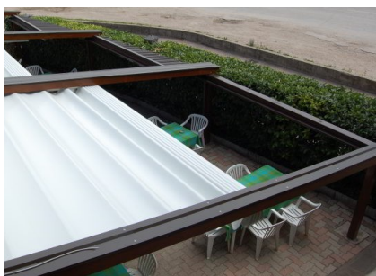
Struttura di copertura: esempio con tendaggio scorrevole
