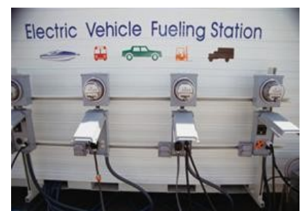
Ricarica veicoli elettrici: esempio di stazione di rifornimento
