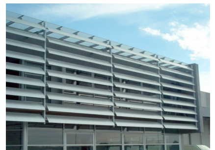
Struttura di ombreggiamento della facciata: esempio con frangisole verticali a lamelle
