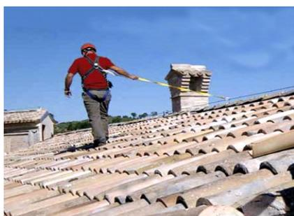
Protezione dalle cadute dall'alto: esempio di sistema di sicurezza
