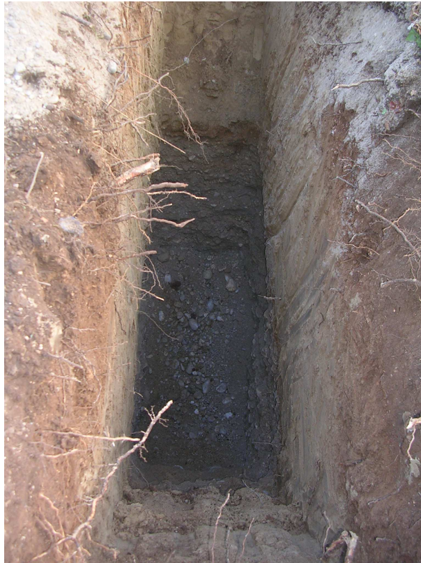
Foto 3: Sezione trincea esplorativa T2
